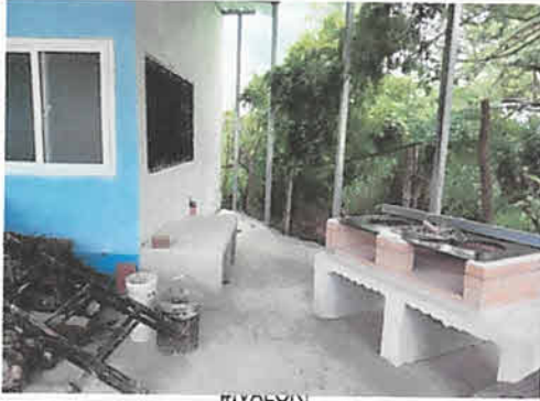
Foto 1: Reparación de estufa rural
