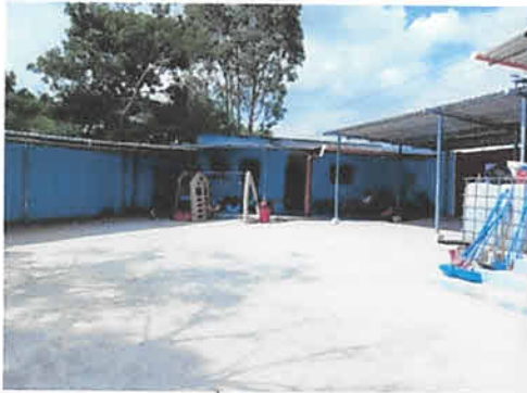
Foto 3: Reparación de techo y ampliación de galera
