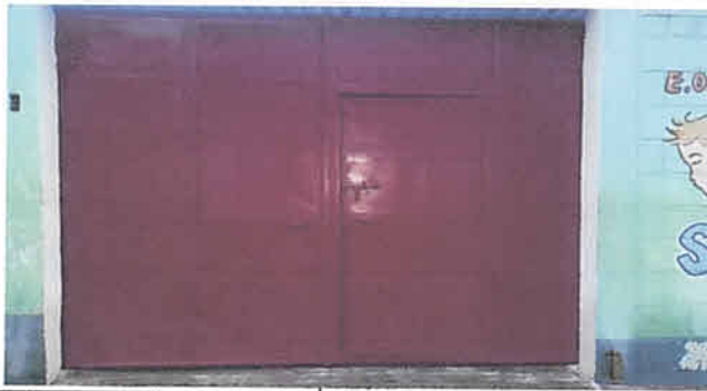
Foto 5: Reparación de portón de ingreso
