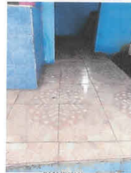
Foto 6: Reparación piso de los sanitarios
