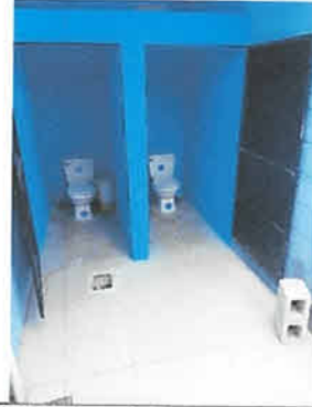
Foto 2: Reparación módulo de sanitarios
